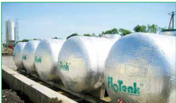
г. Краснодар, строительство свиноводческого комплекса
