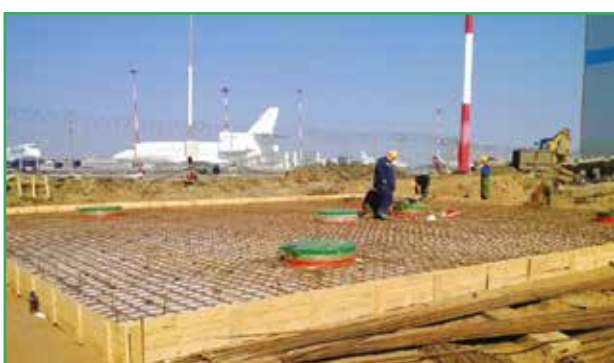
Подготовка и заливка разгрузочной плиты при установке емкостей под проезжей частью
