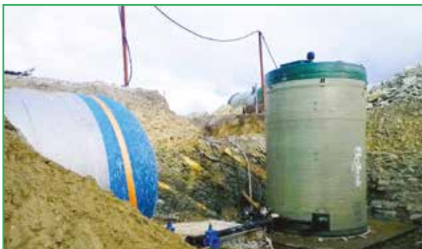
Установка и обвязка вертикальных емкостей
