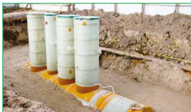
Монтаж технических колодцев с герметизацией стыка с емкостью
