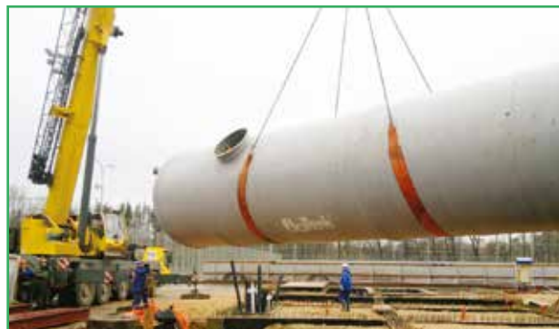
Установка горизонтальных емкостей мягкими стропами
