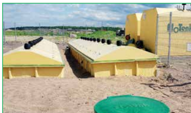
п. Федоровское, Завод по производству труб
