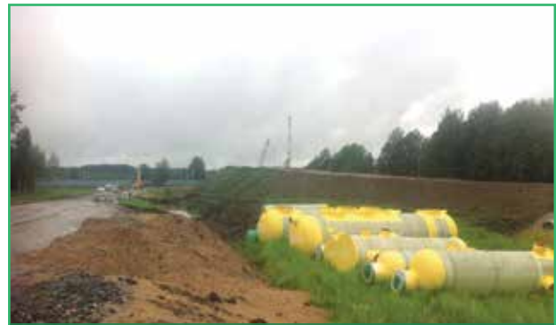
Строительство путепровода на ст. Возрождение
