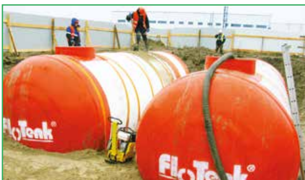
Засыпка емкостей песком с одновременной трамбовкой и заливкой водой
