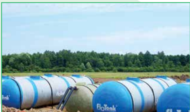
д. Волот, строительство свиноводческого комплекса
