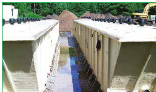
Монтаж аэротенков к плите талрепами и анкерами
