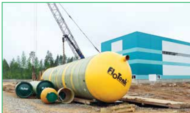
г.Тихвин, строительство котельной
