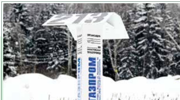
Квадратный профиль для использования в качестве корпуса контрольно-измерительных пунктов (КИП)
