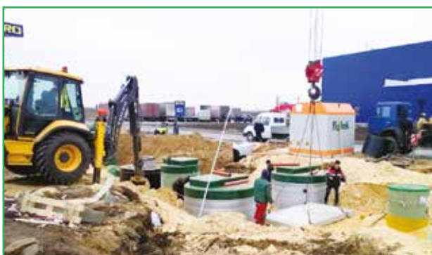
Устройство плиты при малом диаметре емкости
